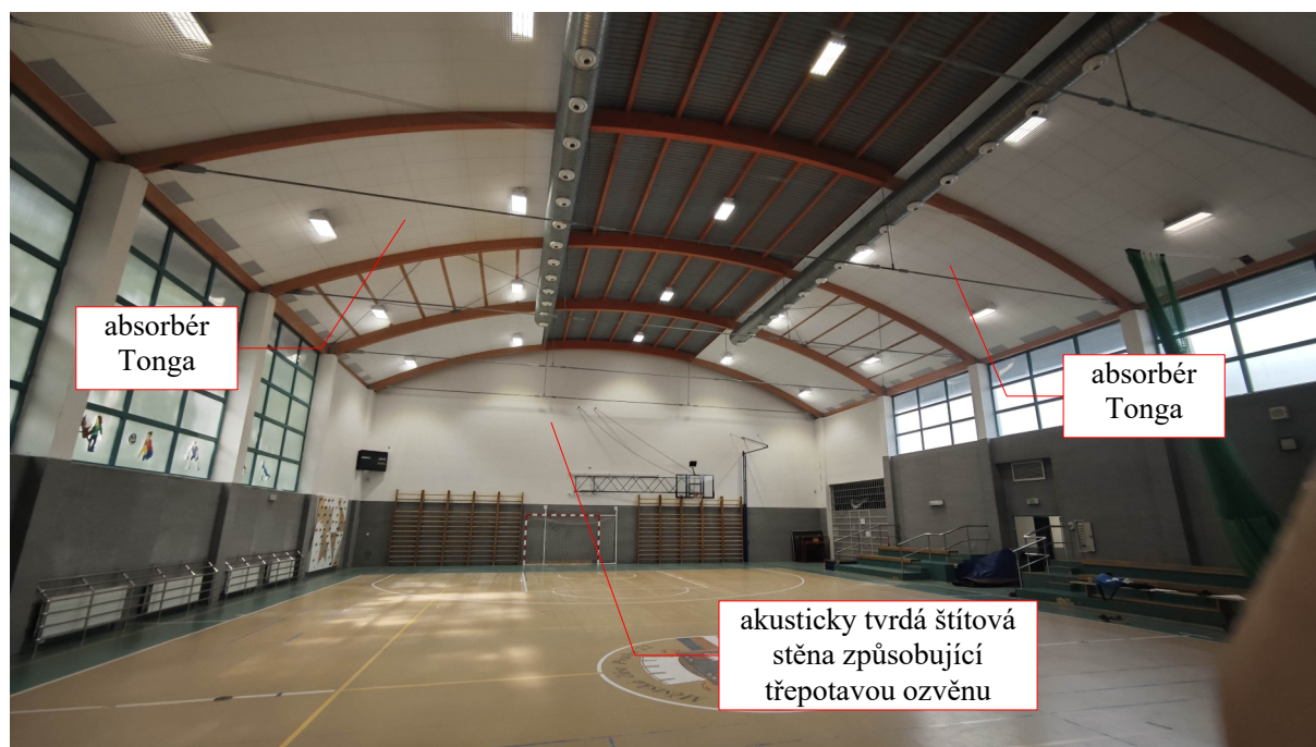
Obr. 2 – fotografie absorberu Tonga na stropě tělocvičny
